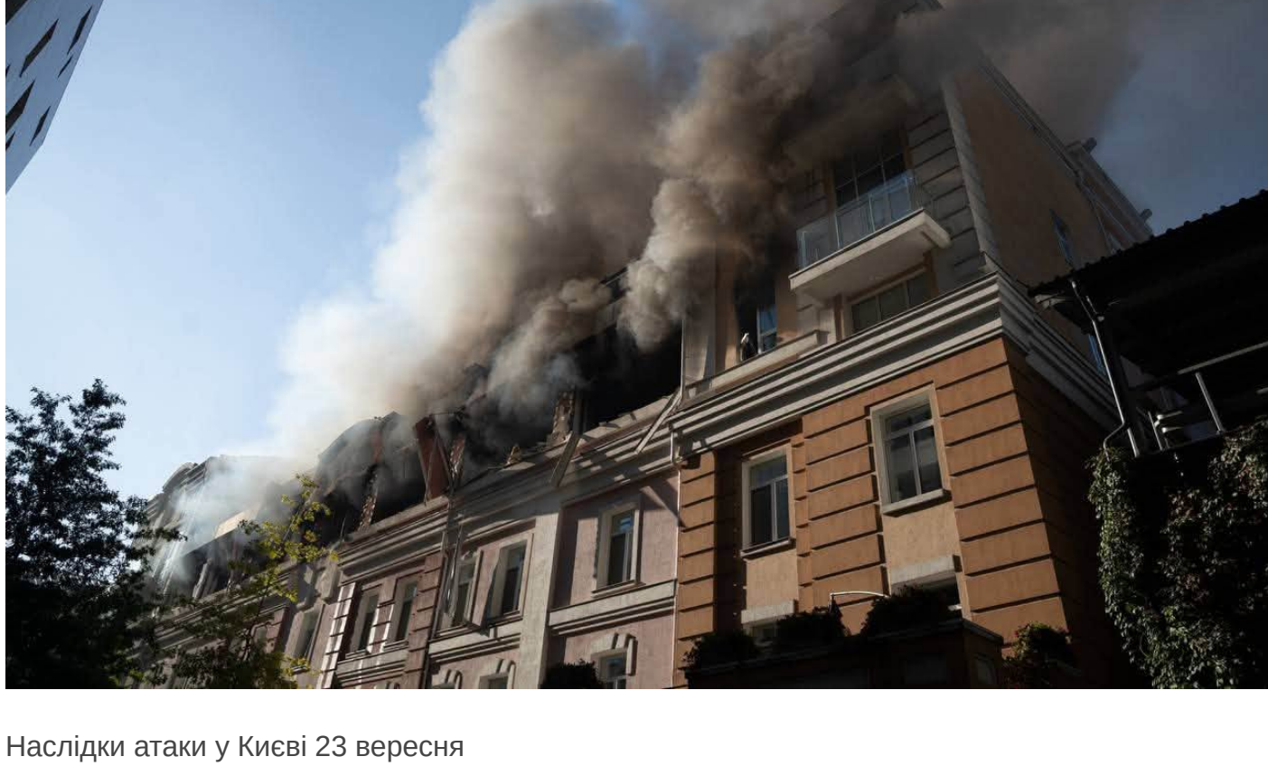
Наслідки атаки у Києві 23 вересня фото: ДСНС Києва
