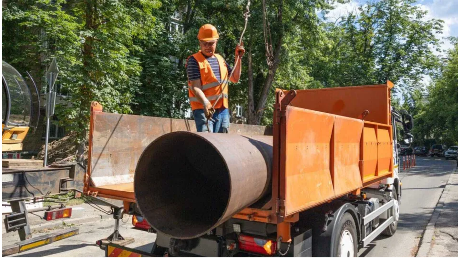
КМДА: Термін добудови резервної теплотраси є критично стислим Foto: kylvcity.gov.ua
