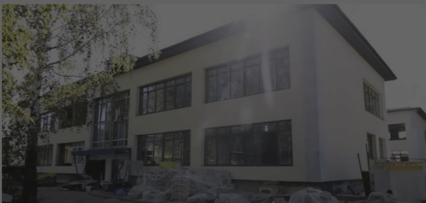
Хід капремонту станом на вересень 2024 року ( джерело – скріншот з відео )
