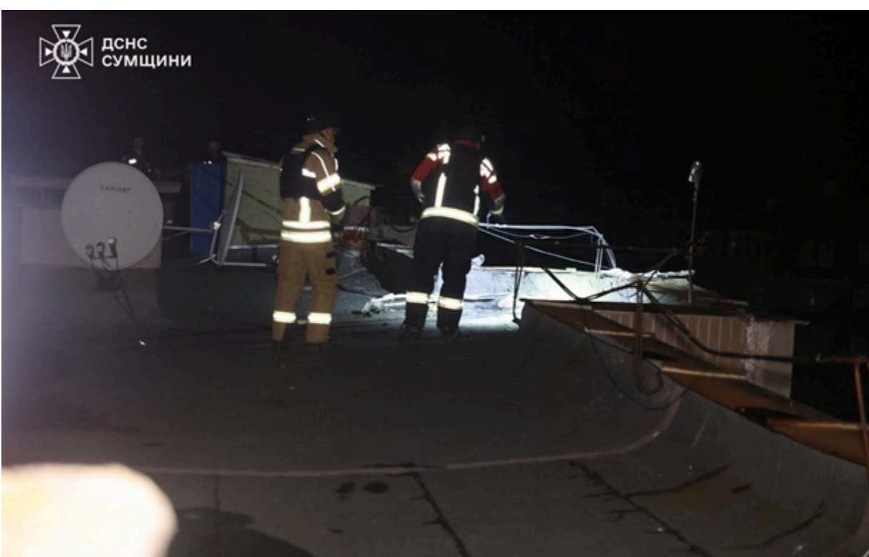
Фото: ДСНС Ударний безпілотник влучив у покрівлю багатоповерхівки
