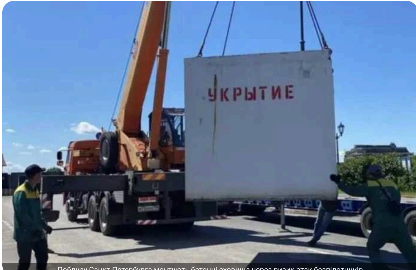
Поблизу Санкт-Петербурга монтують бетонні сховища через ризик атак безпілотників
