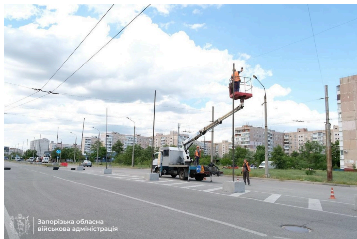
Встановлення антидронових сіток у Запоріжжі фото: Запорізька ОВА
