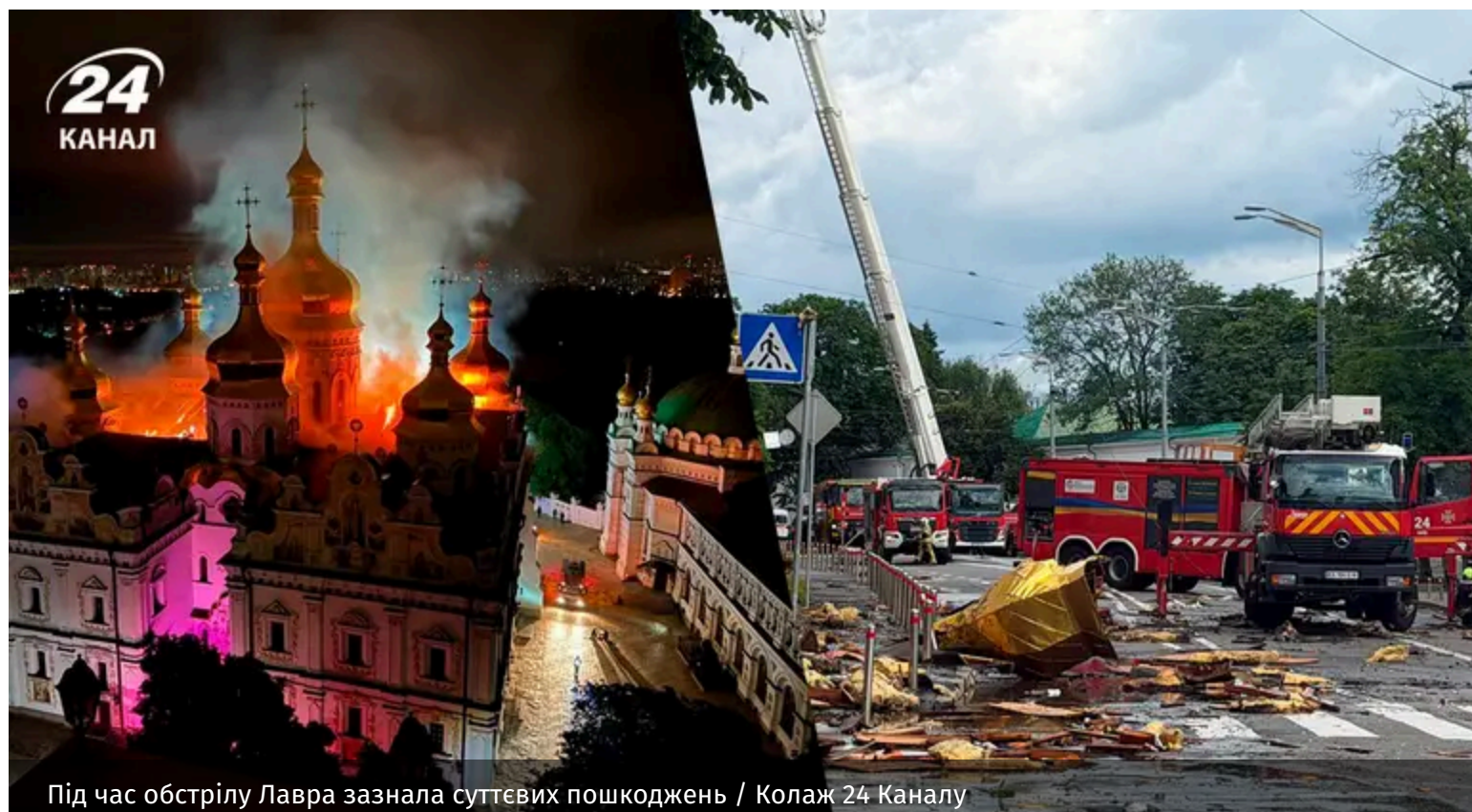
Під час обстрілу Лавра зазнала суттєвих пошкоджень / Колаж 24 Каналу
