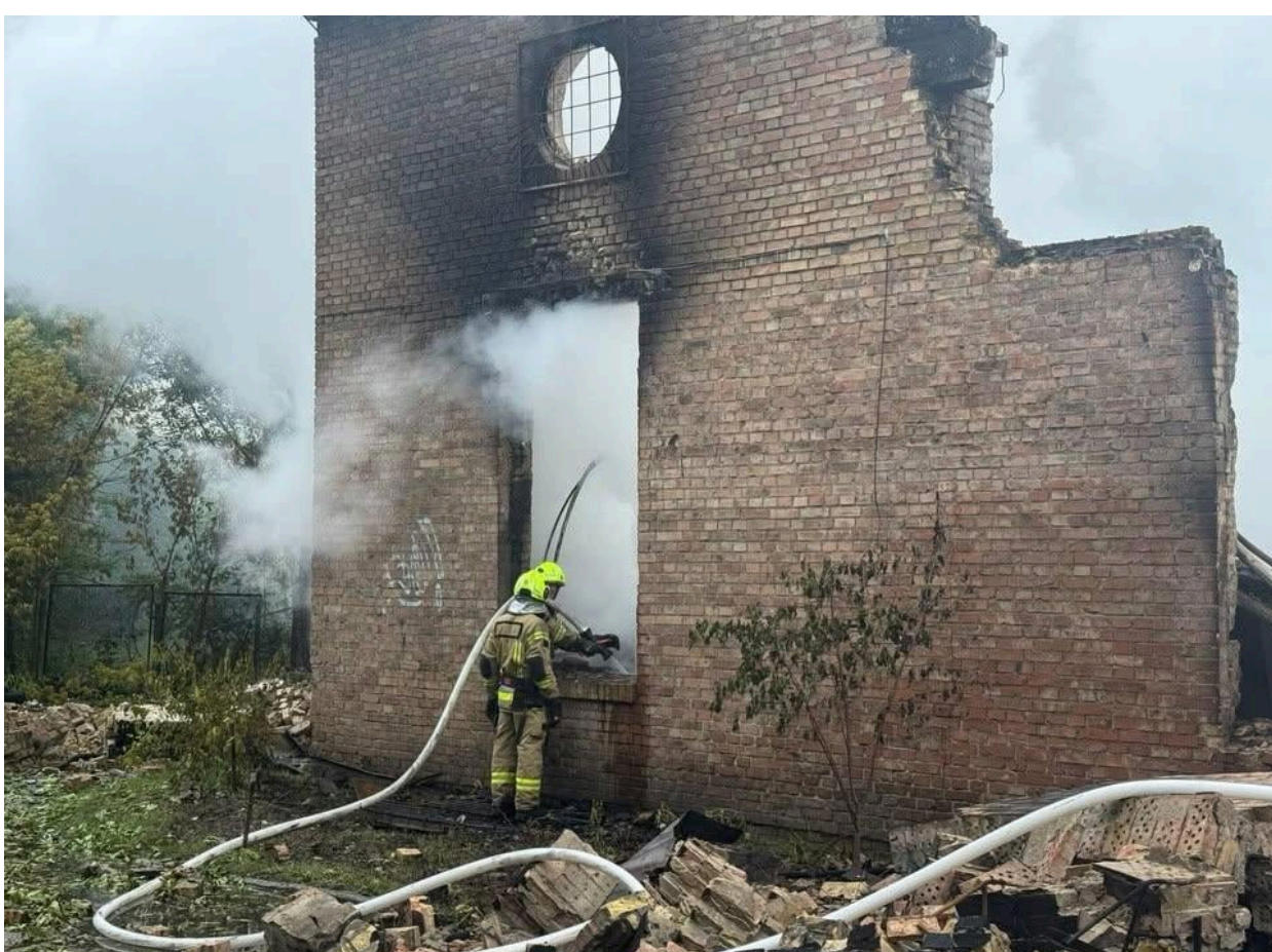
Росіяни зруйнували будівлі кіностудії Довженка /фото - Facebook кіностудії Довженка
