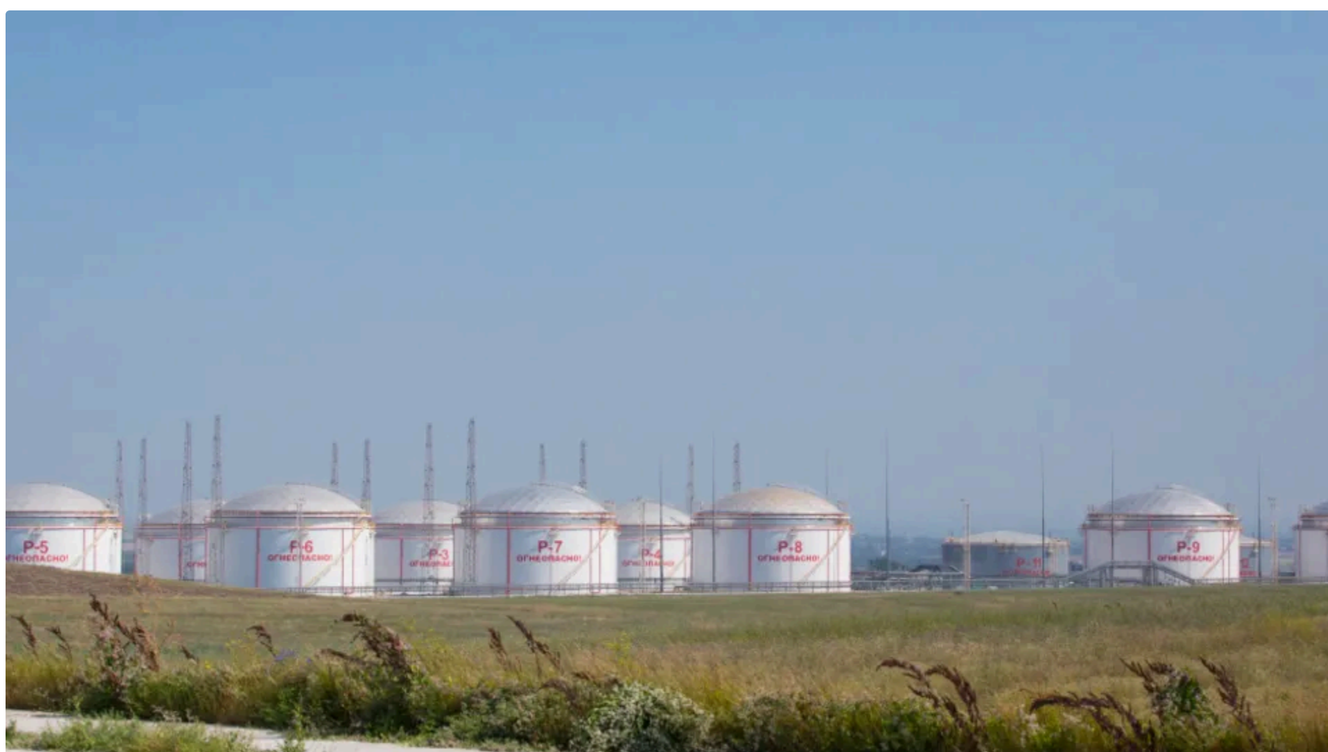
СБУ уразила найбільший на півдні РФ термінал із резервуарним парком у 28,8 тис. м³ Фото: tamanneftegas.ru
