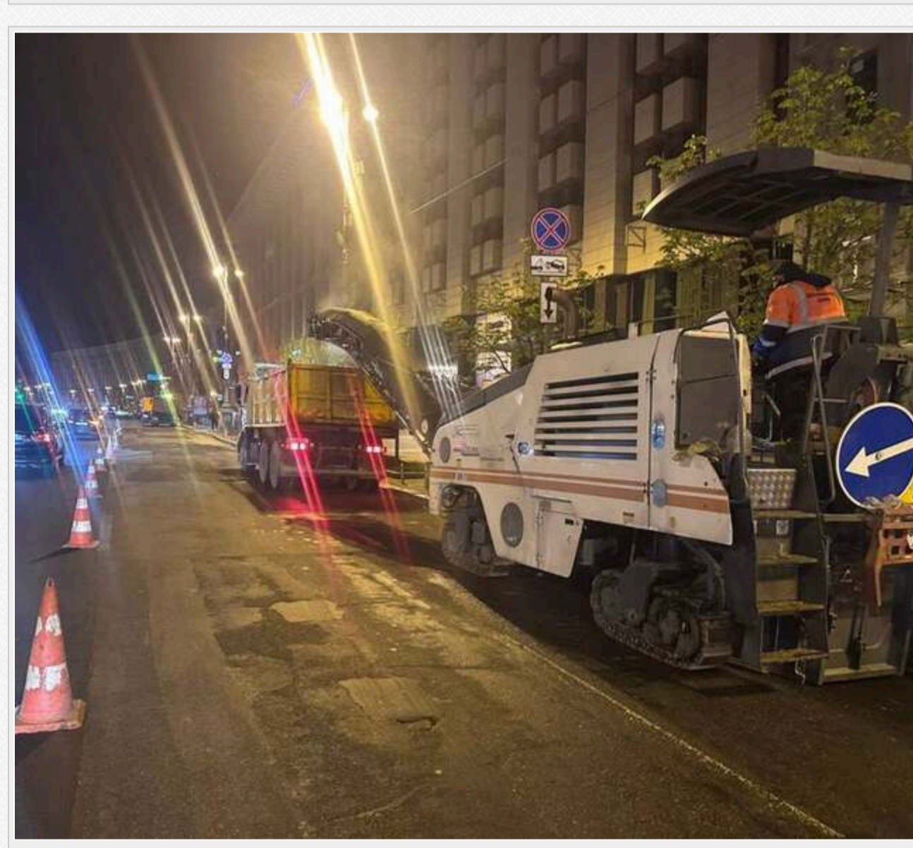
Ремонтні роботи на Хрещатику у квітні 2026 року ( джерело – Шевченківська РДА)
