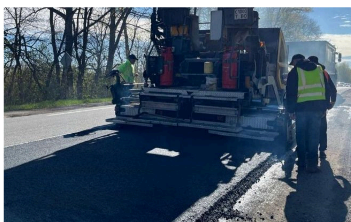
Фото: ремонт дороги (l.me/s/vyrudefenka)
