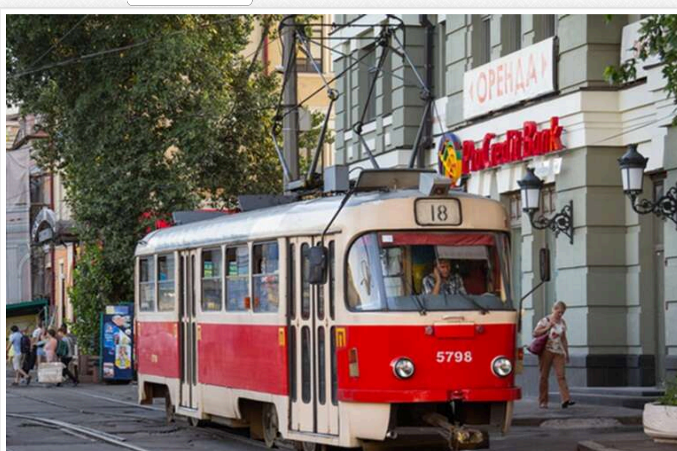
У Києві прорвало трубу під трамвайною колією: утворилась вирва
