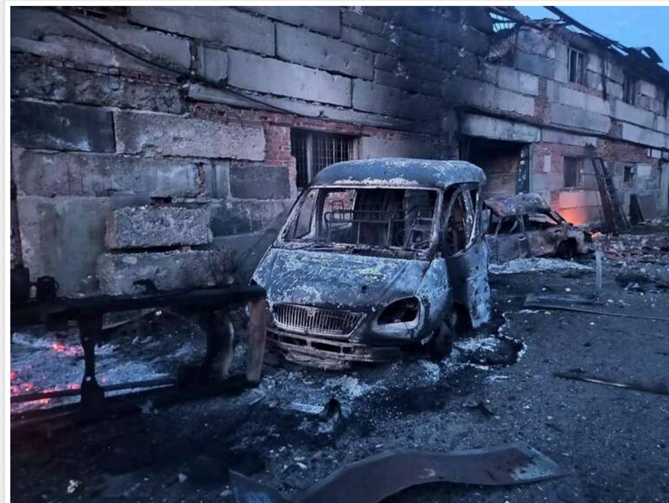
У Слов'янську шість дронів атакували будівельну базу: пошкоджено техніку та приміщення
