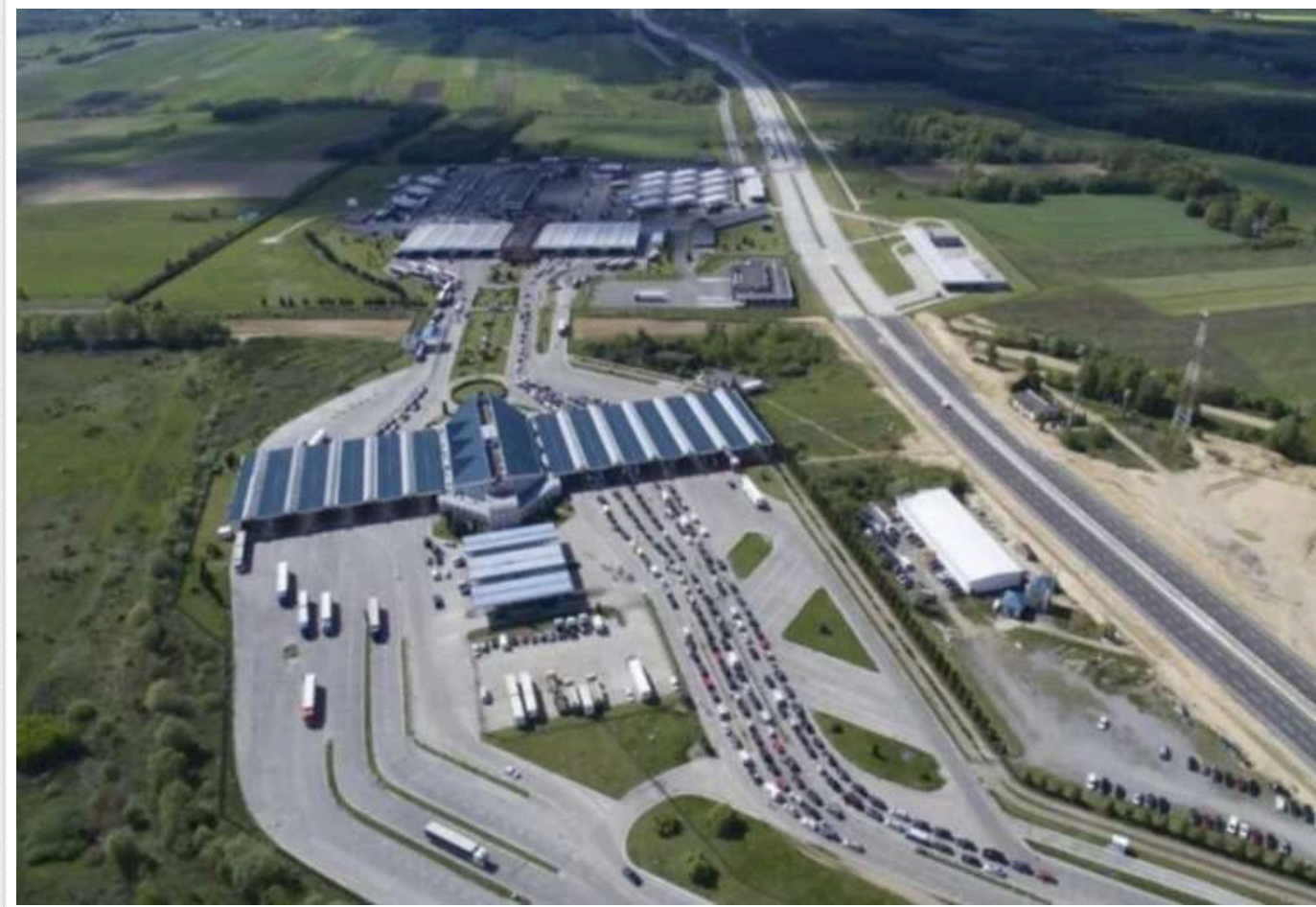
На пункті пропуску «Корчова - Краковець» з 8 травня стартує ремонт: можливі черги
