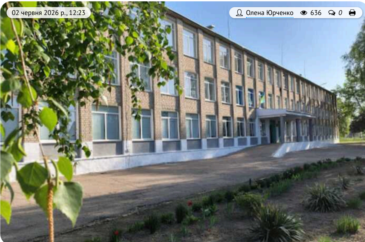
Плитка і бетон дорожчі вдвічі: як компанія сина ексчлена харківського виконкому «накрутила» мільйони на прифронтовому ліцеї
