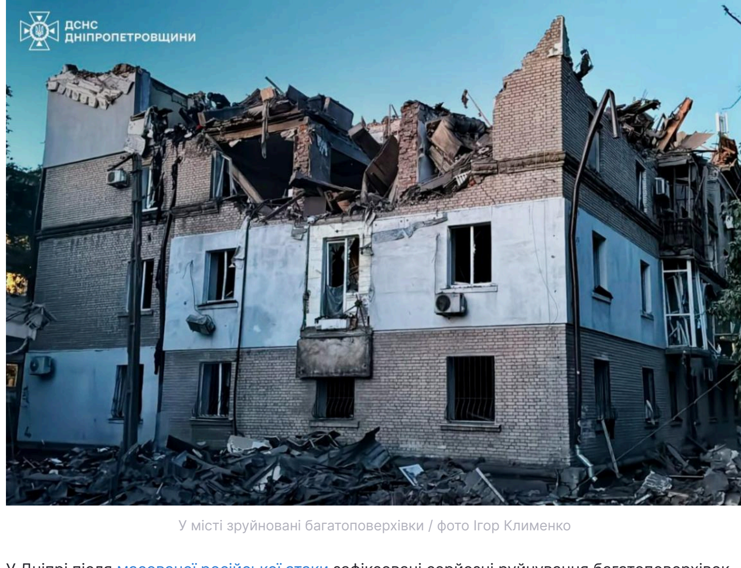
У місті зруйновані багатоповерхівки / фото Ігор Клименко
