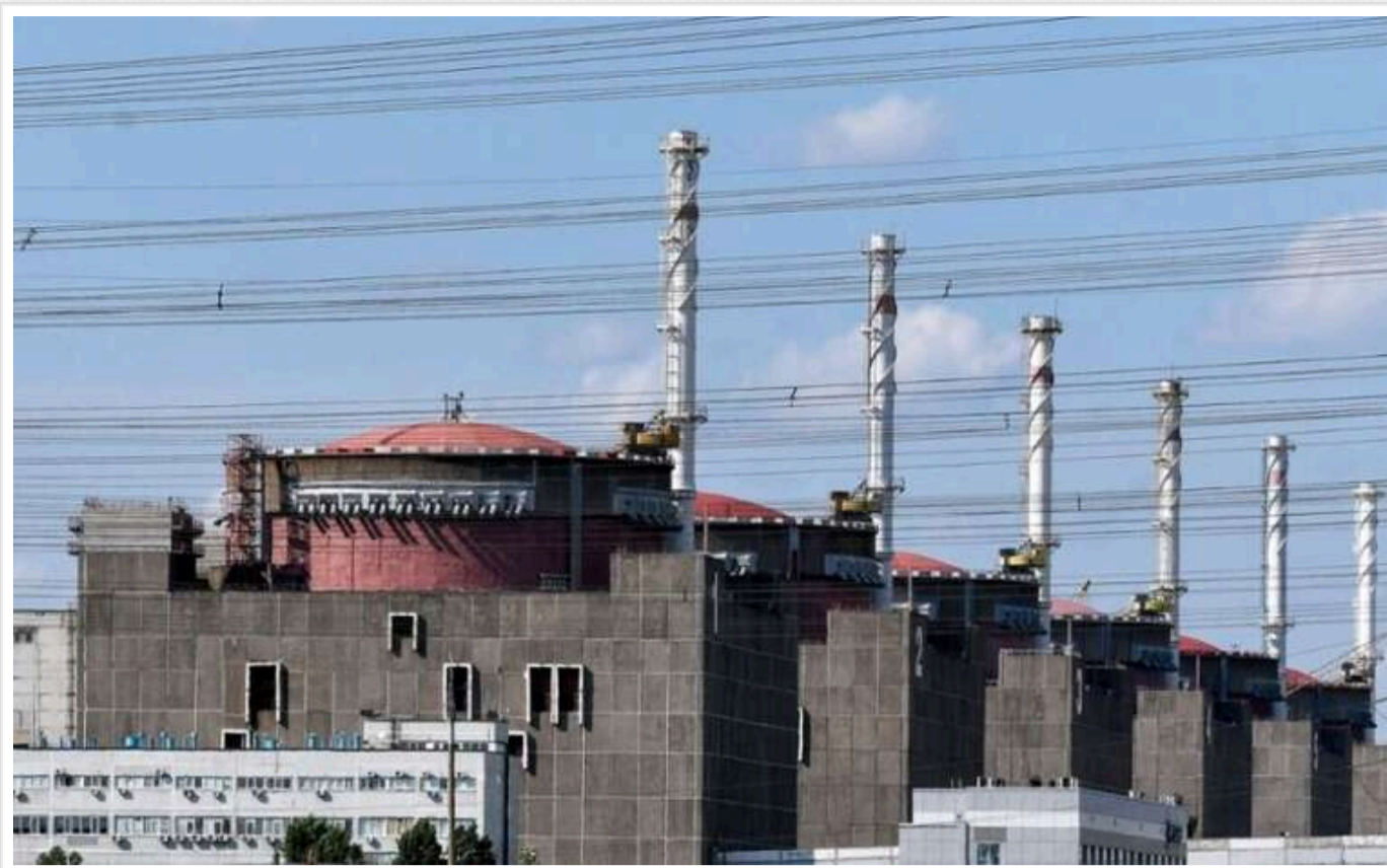
Енергетики відремонтували пошкоджену лінію електропостачання Запорізької АЕС
