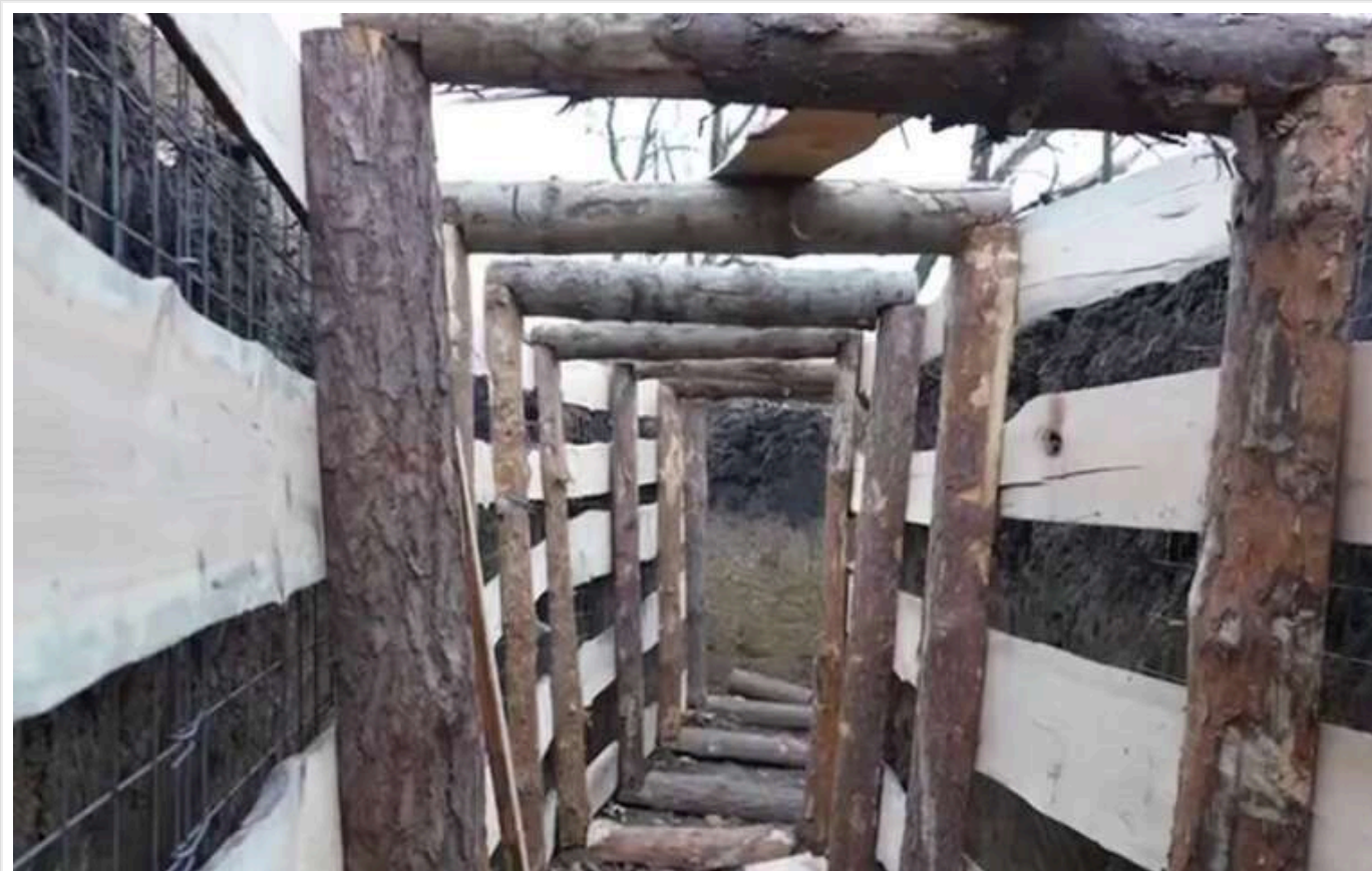
Зеленський ознайомився із будівництвом оборонних споруд на Донеччині
