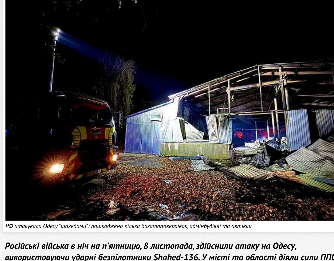
РФ атакувала Одесу "шахедами": пошкоджено кілька багатоповерхових, адмінбудівлі та автвікни
