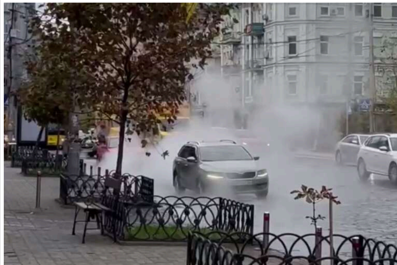
У центрі Києва прорвало трубу
