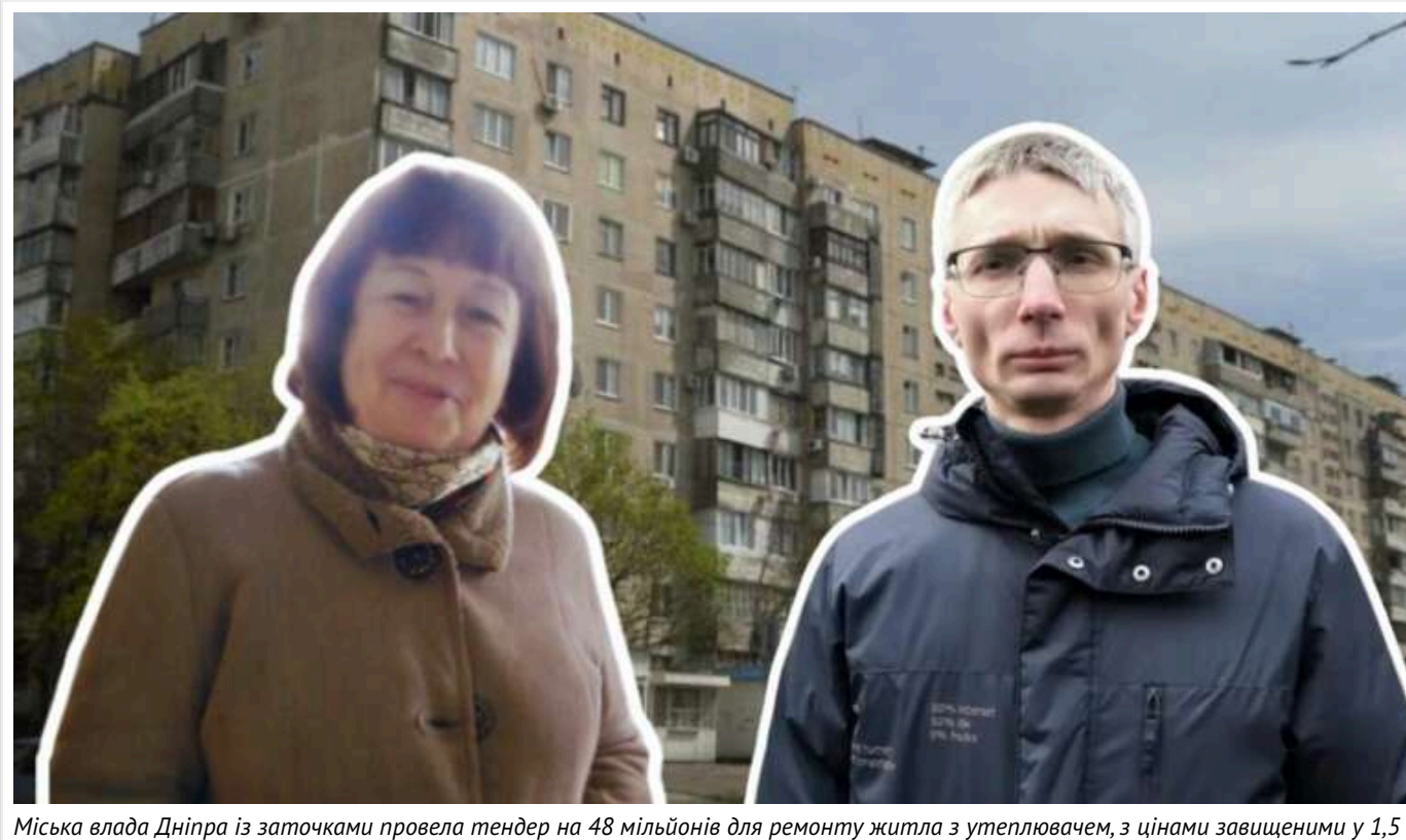
Міська влада Дніпра із заточками провела тендер на 48 мільйонів для ремонту житла з утеплювачем, з цінами завищеними у 1,5 раза
