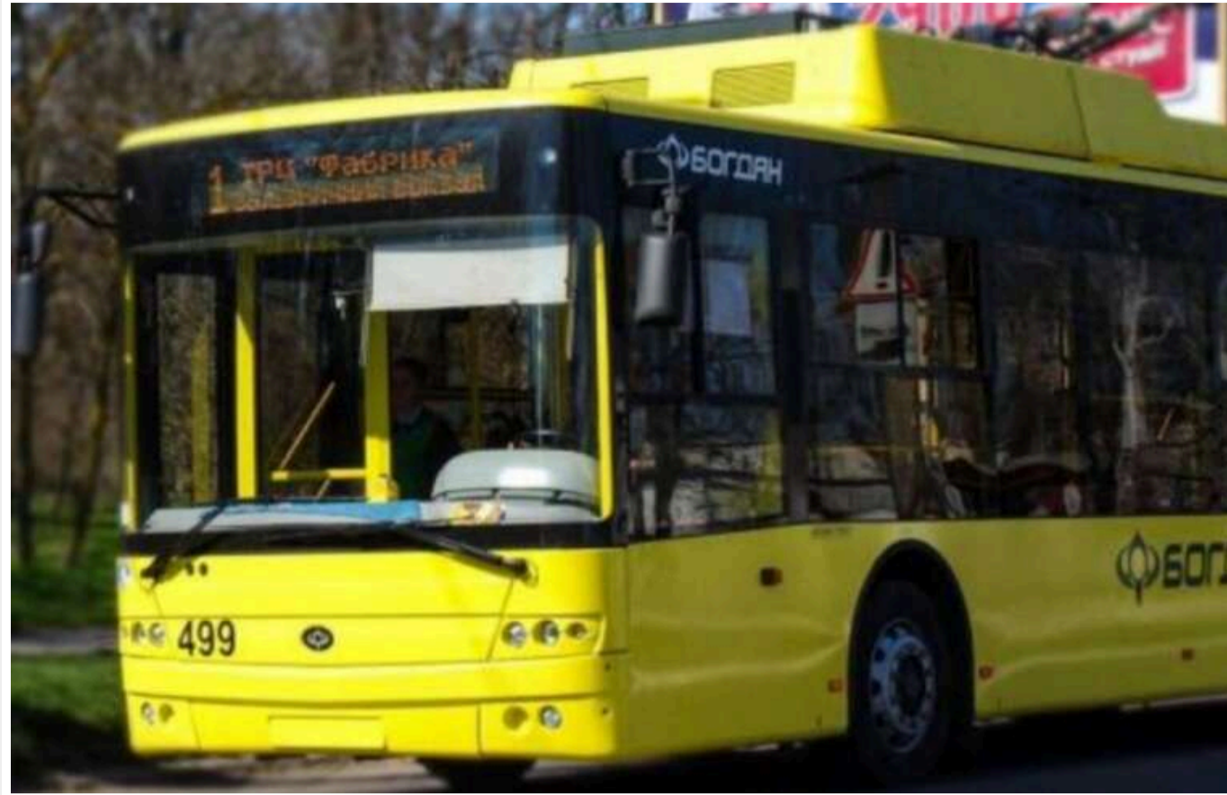
У Херсоні росіяни обстрілами пошкодили контактну мережу: не працює електротранспорт
