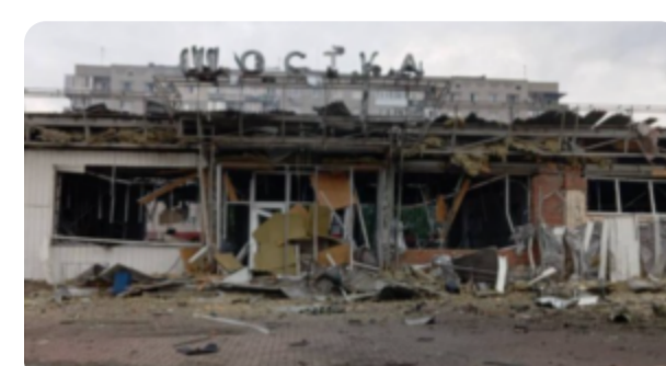
09:02 30.05.2026 РФ десятками дронів знищило будівлю вокзалу у Шостці – Центр журналістських розслідувань
