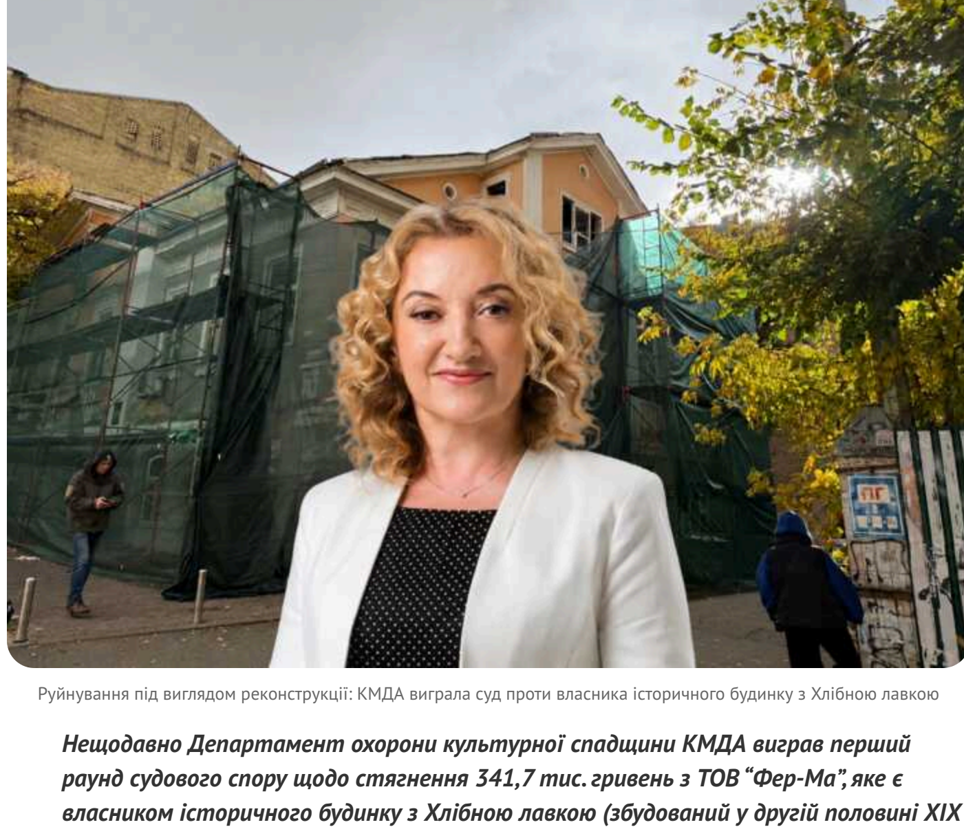
Руйнування під виглядом реконструкції: КМДА виграла суд проти власника історичного будинку з Хлібною лавкою
