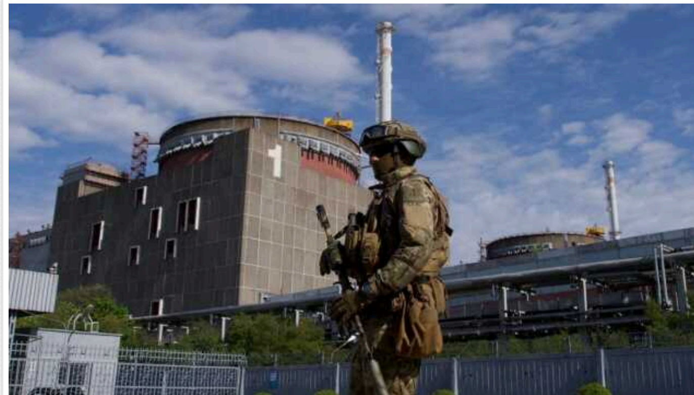
Запорізька АЕС на межі блекауту: окупанти завдали удару по підстанції та відключили лінію електропостачання
