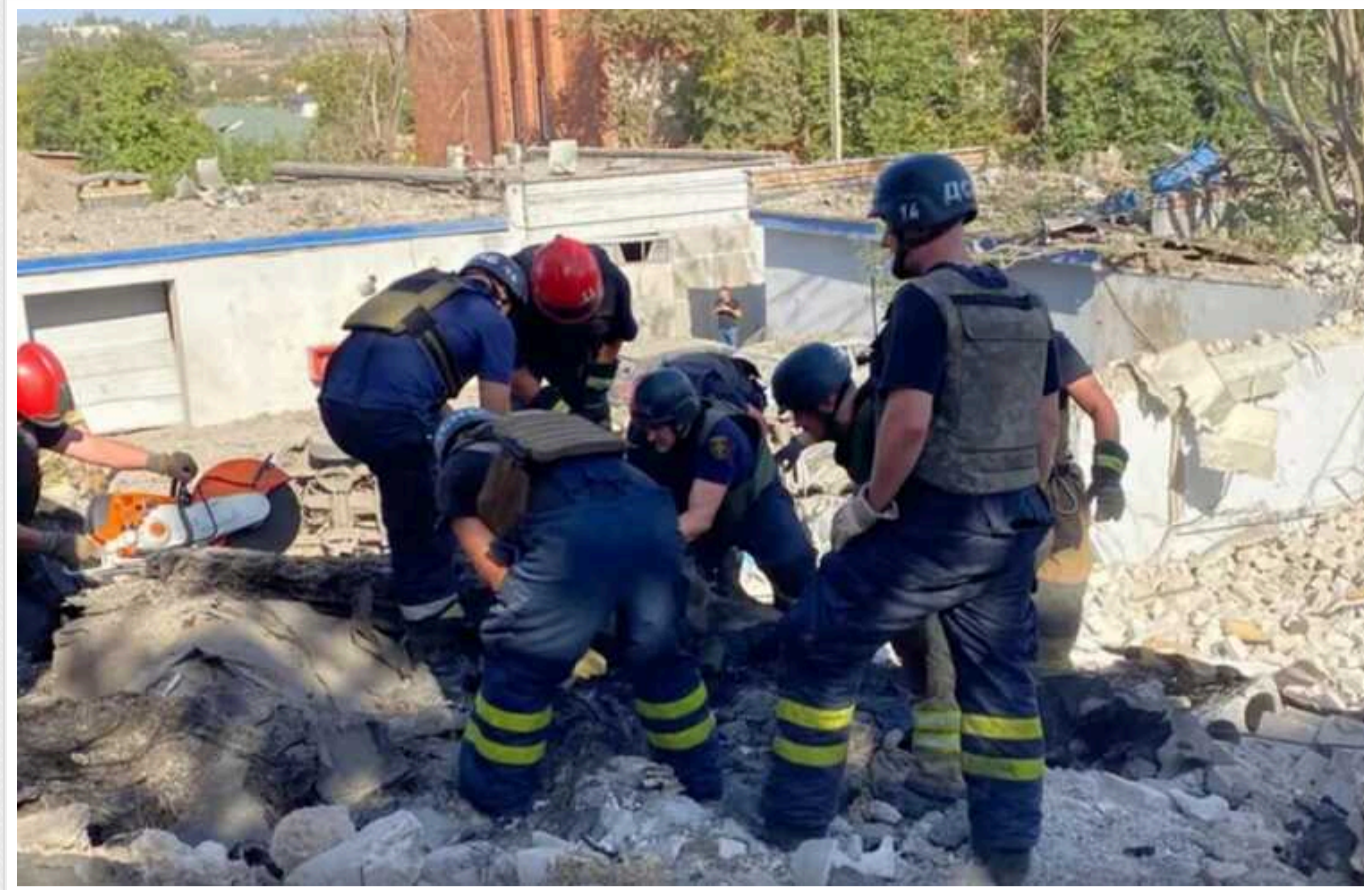
Удар по Кривому Рогу: на місті прильоту триває розбір завалів
