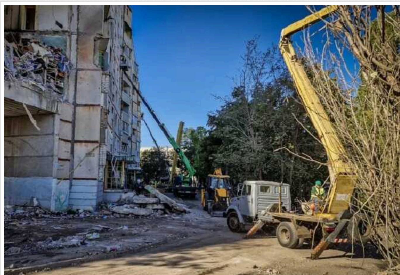
ДСНС: Під завалами багатоповерхівки в Харкові, куди влучив КАБ, може бути тіло людини
