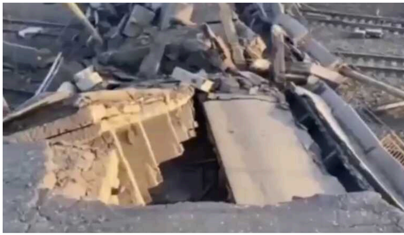
У мережі публікують відео зруйнованого моста в Покровську
