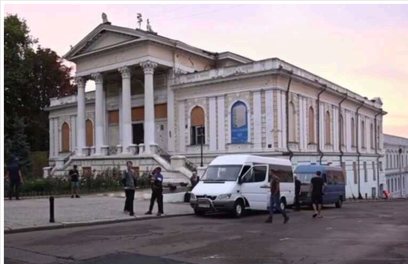
Одеські комунальники вирушили на Донеччину для будівництва фортифікаційних споруд
