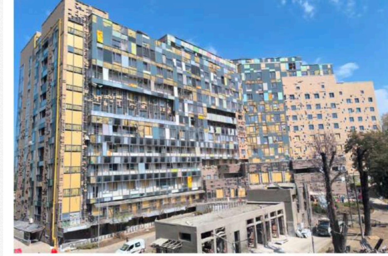
Провідний експерт будівельний з технічного обстеження будівель та споруд АЕ № 005340 Олександр ВАСЕНЬОВ Київ 2024
