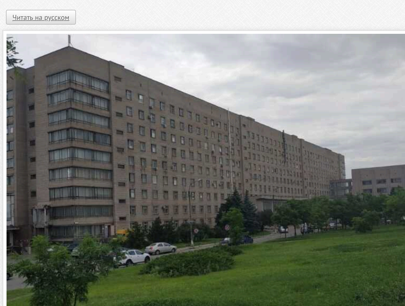
У Кривому Розі за проектом «Великого будівництва» хочуть із «заточками» освоїти 1,4 мільярда на ремонті лікарні
