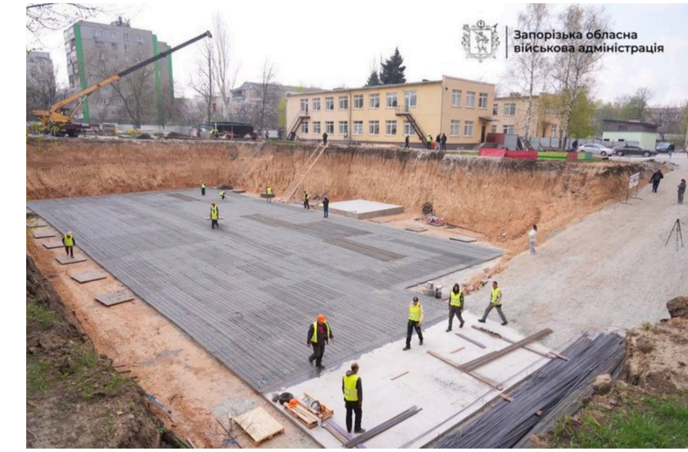
Будівництво протирадіаційного укриття закладу дошкільної освіти «Трайлик» у Запоріжжі. Запорізька ОВА.
