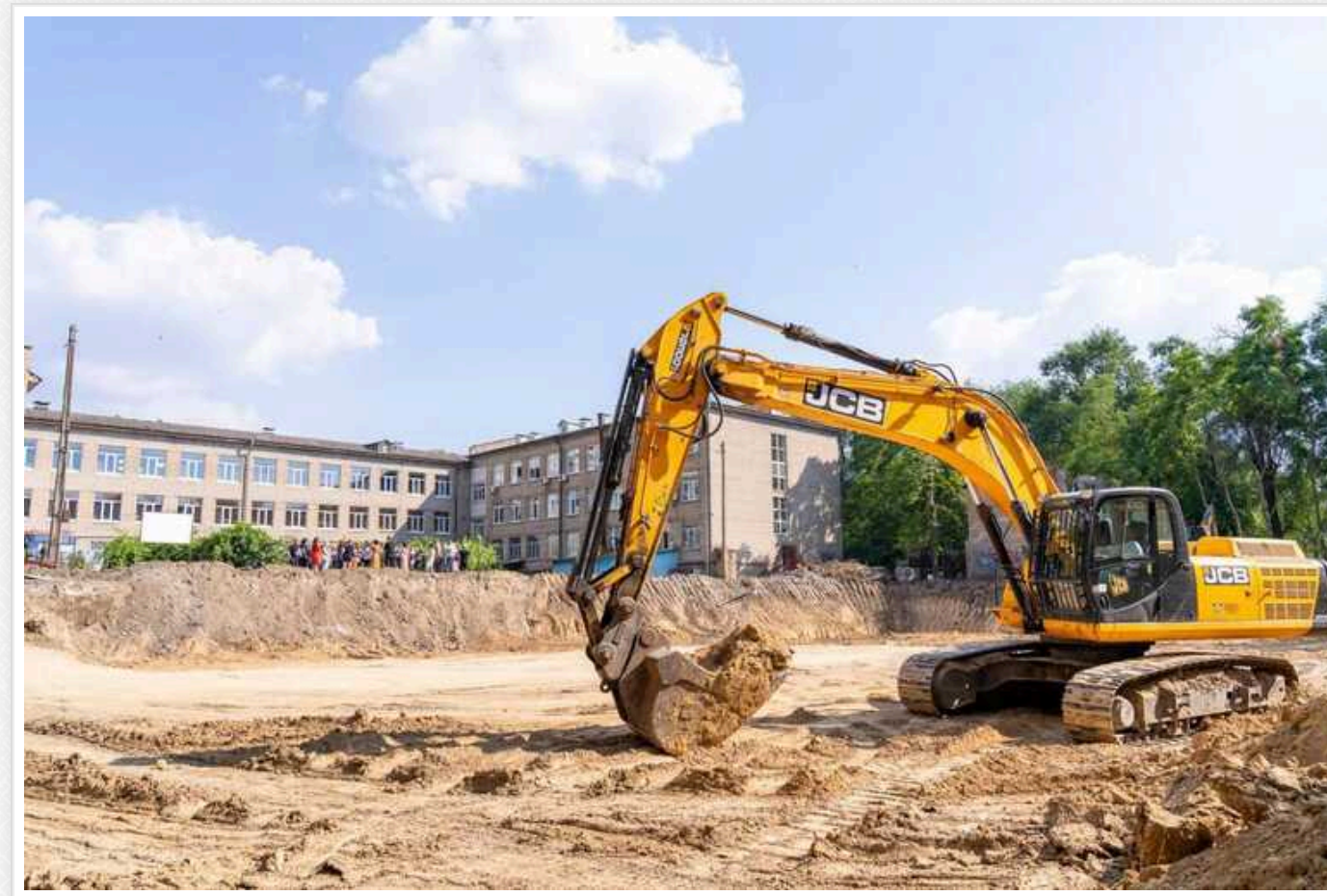
На Запоріжжі розпочали будівництво підземних шкіл у п'яти місцях, - Федоров
