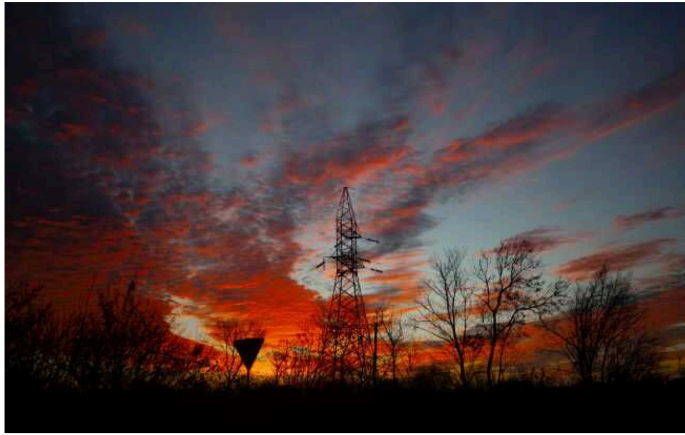
На сході РФ вдарила по підстанції: відбулися знеструмлення та затримки поїздів
