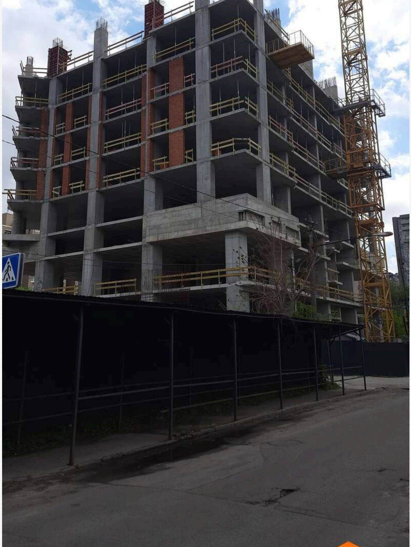
Будмайданчик ЖК "The Resort" станом на квітень 2024-го (фото – "Лун")
