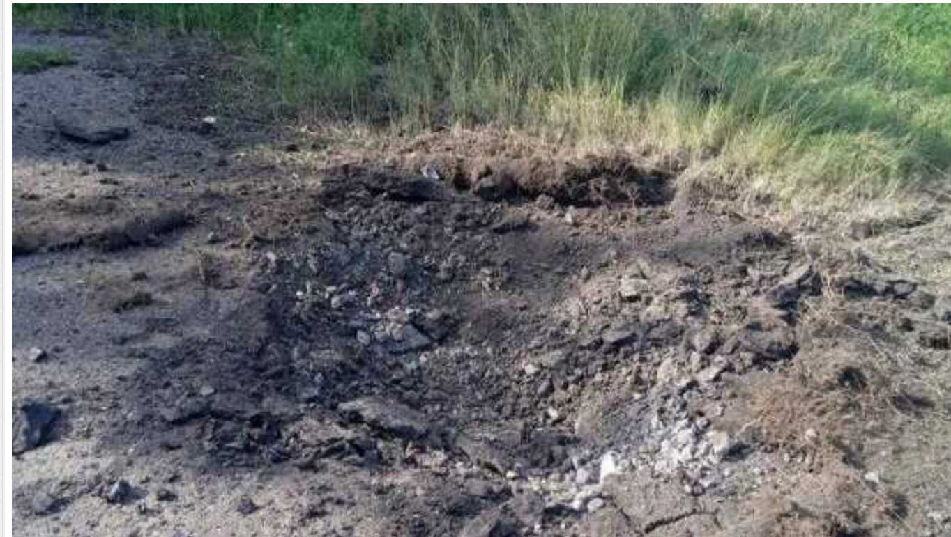
У Харкові внаслідок удару росіян КАБом пошкоджені 4 приватні будинки
