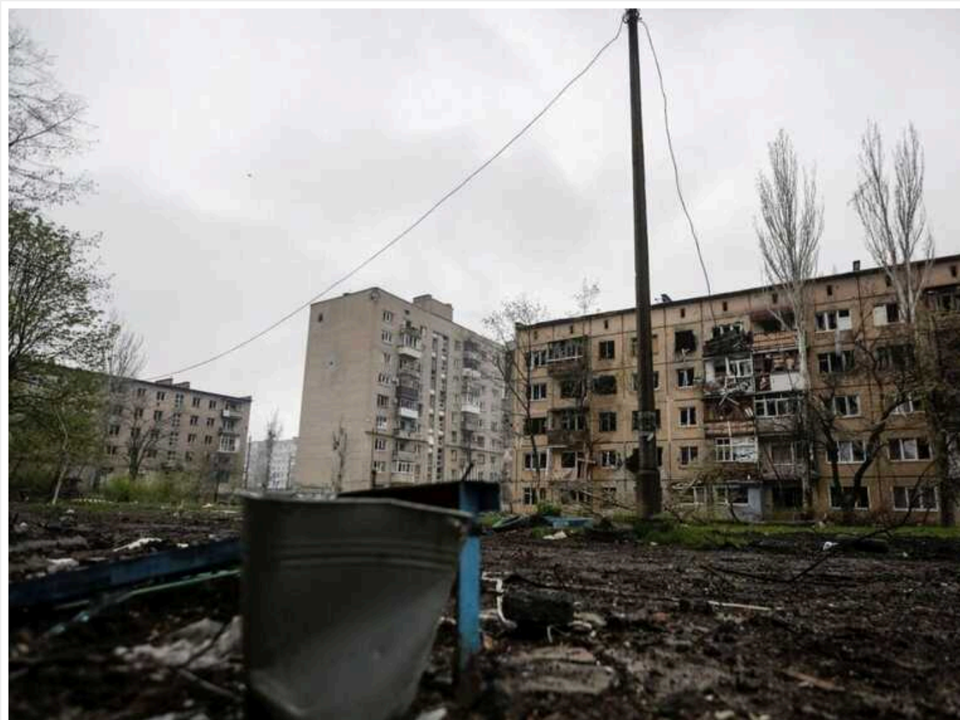
Окупанти зруйнували в Україні щонайменше 210 тисяч будівель, – NYT
