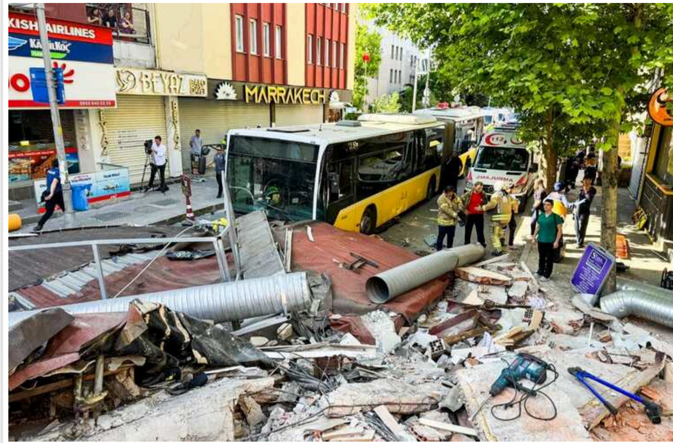
Обвал будинку в Стамбулі: стало відомо про одного загиблого та вісьмох постраждалих
