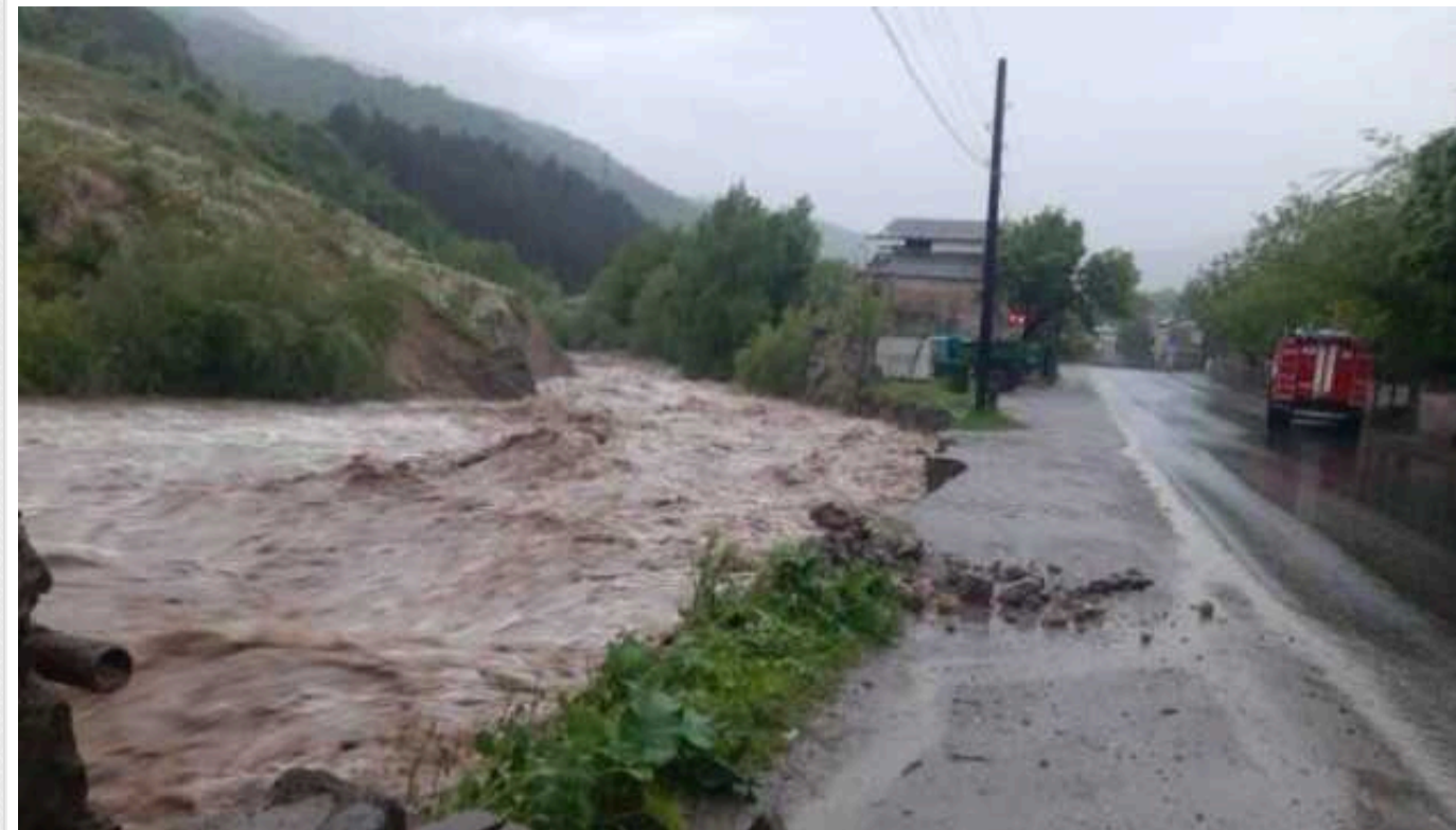
У Вірменії через повінь зруйновано дорогу та затоплено будинки
