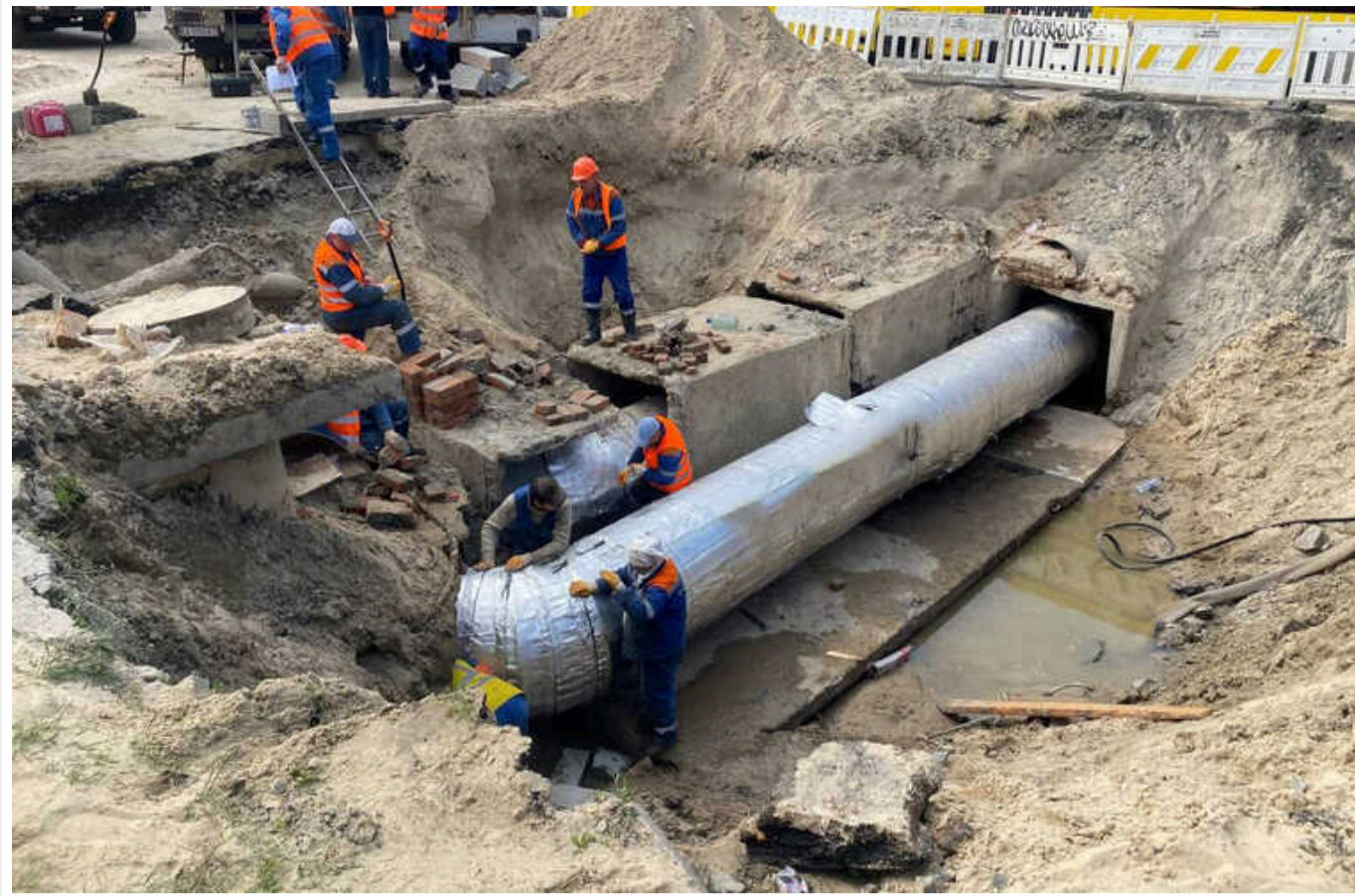
У Києві продовжуються роботи з відновлення прориву водопроводу біля станції метро «Либідська»
