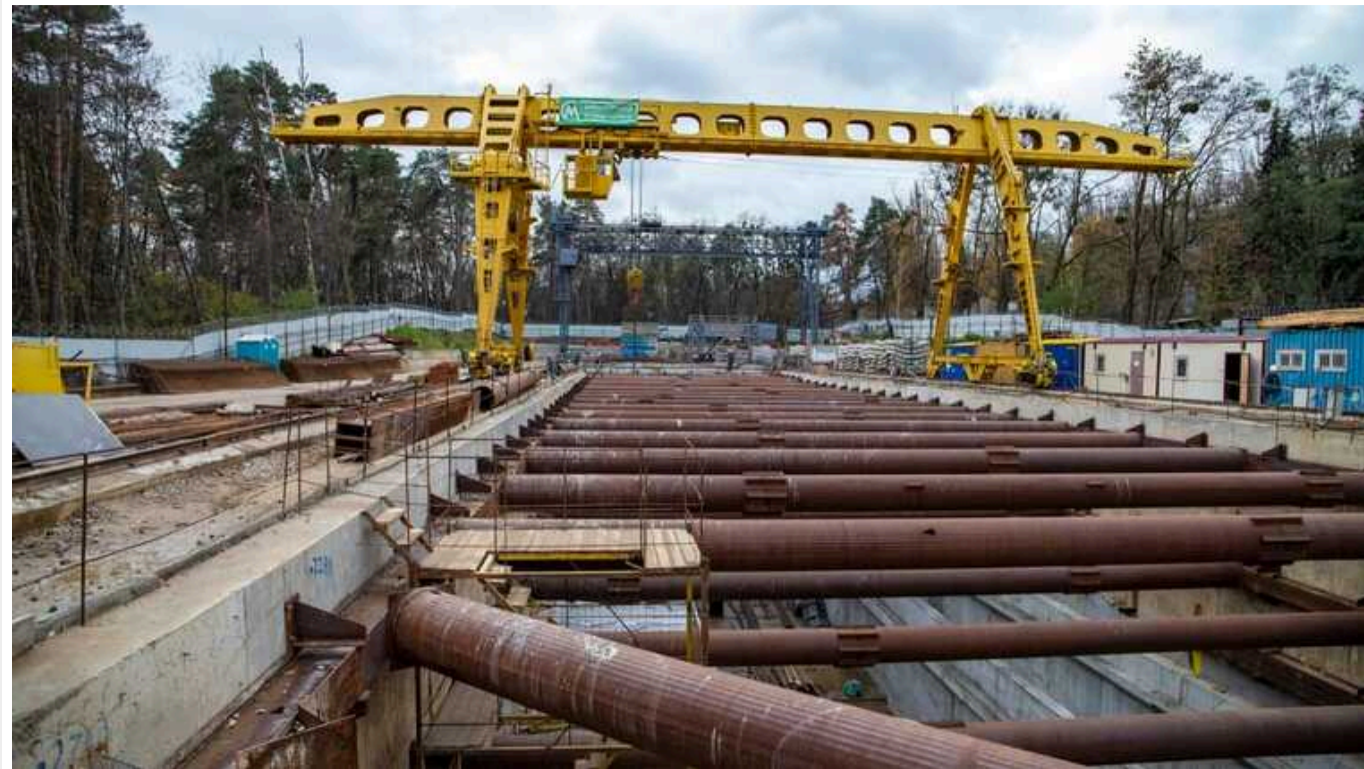
У Києві оголосили тендер на майже 14 мільярдів гривень на продовження будівництва метро на Виноградар
