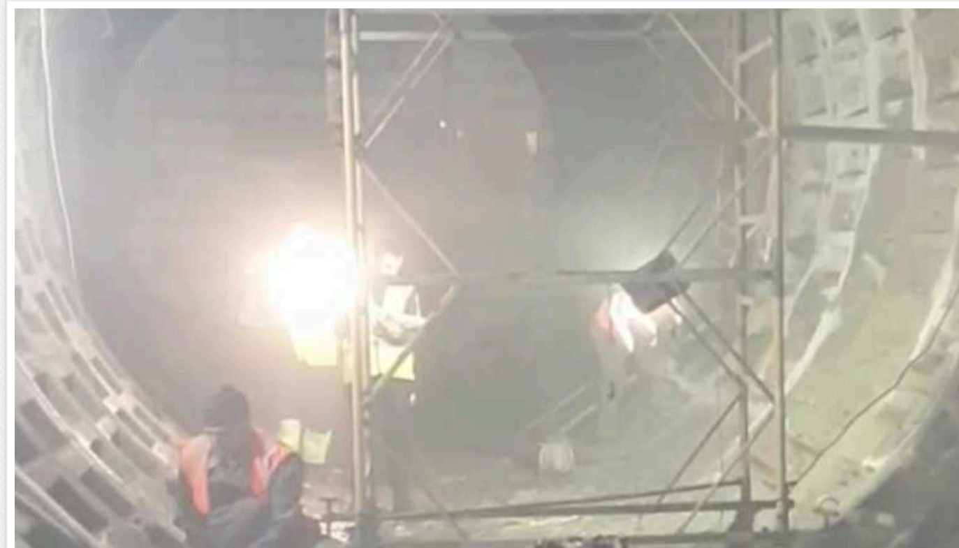
Між станціями "Деміївська" та "Либідська" розпочався демонтаж залізобетонних тюбінгів, - КМДА
