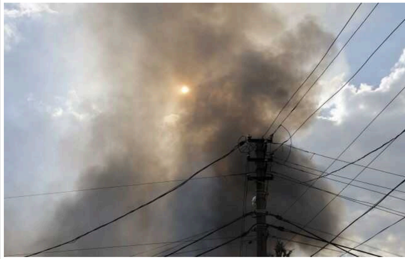
В окупованому Севастополі ГУР підірвало підстанцію, – ЗМІ
