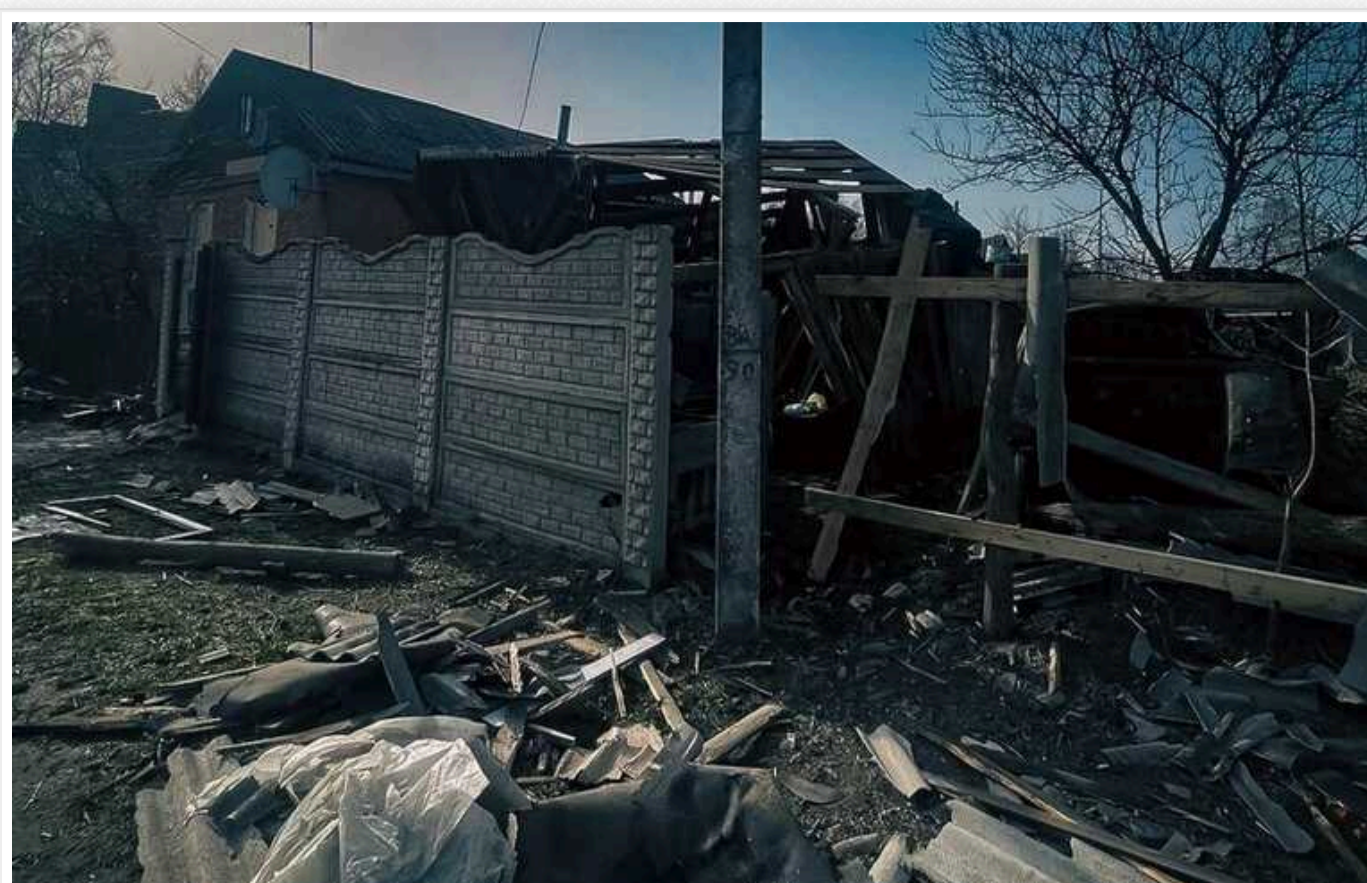
У Нацполіції показали наслідки ворожих обстрілів Сумщини: пошкоджено приватні будинки, травмовано одну людину
