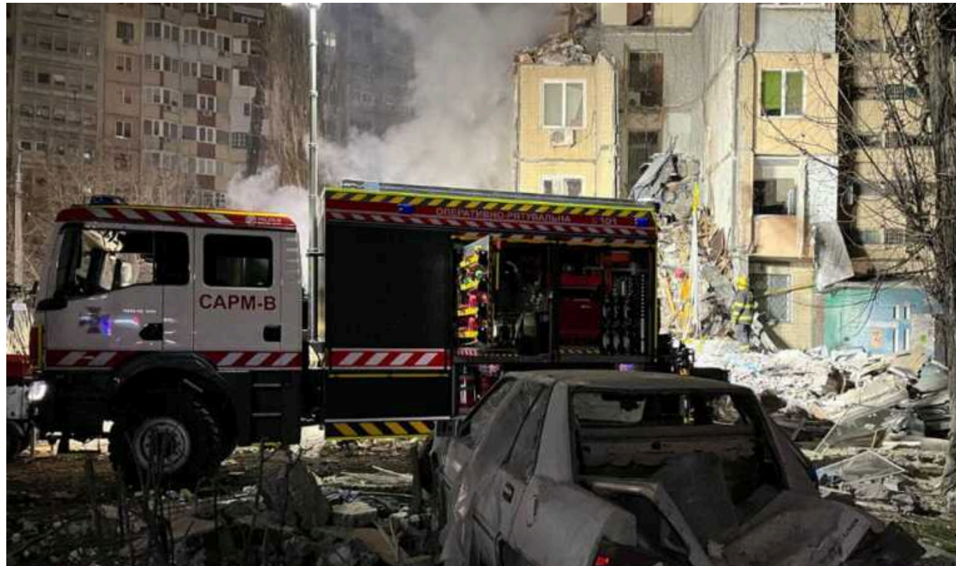
Унаслідок падіння збитого дрона РФ на житловий будинок у ніч проти 2 березня в Одесі повністю зруйновано 8 квартир
