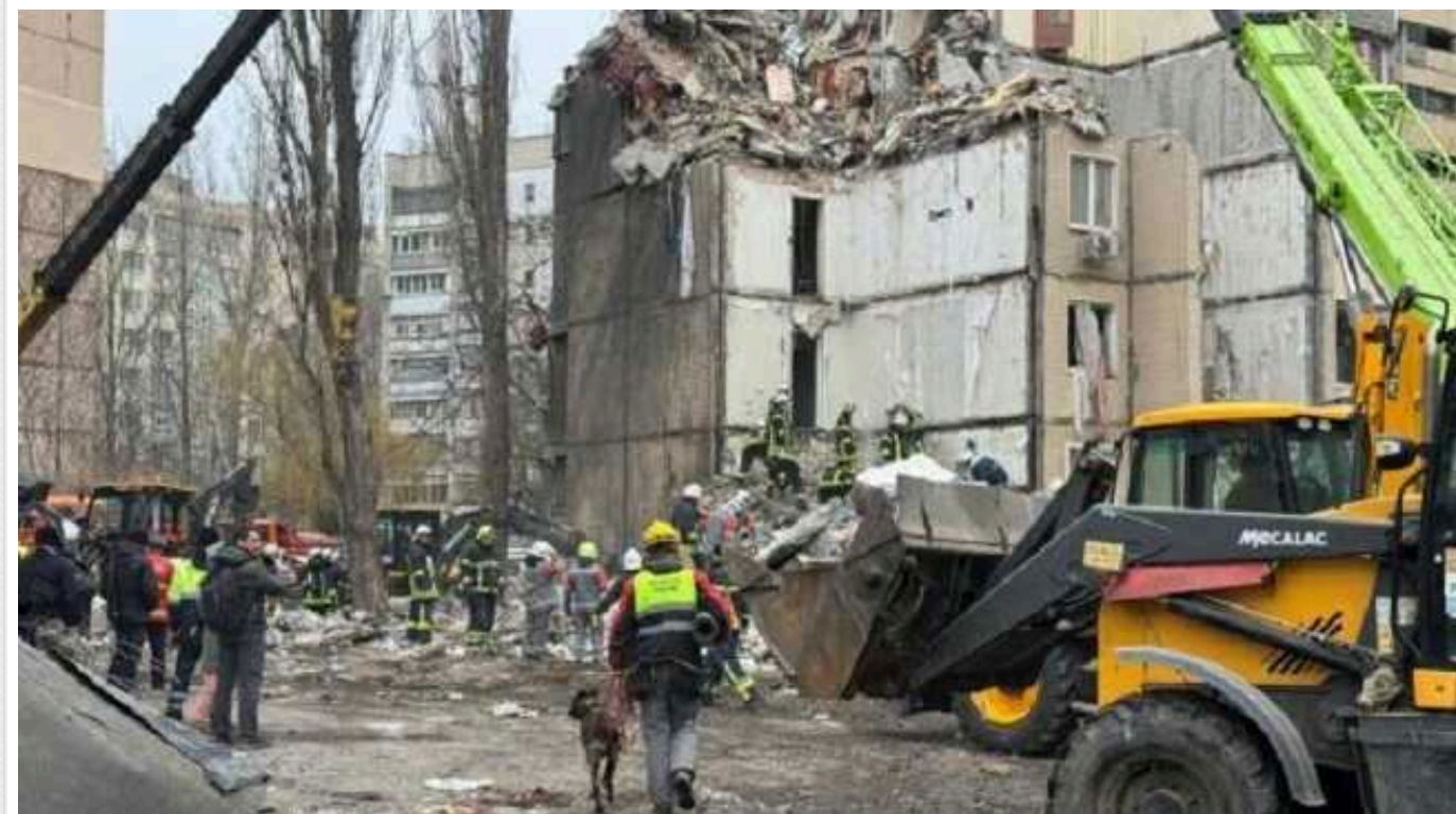
Удар РФ по Одесі: експерт пояснив, як "Шахед" міг зруйнувати цілий під'їзд
