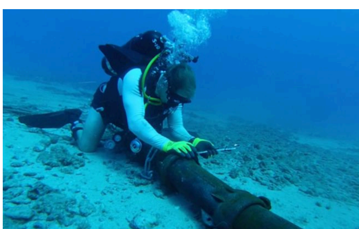
Фото: ремонт підводного інтернет-кабелю (Скриншот)
