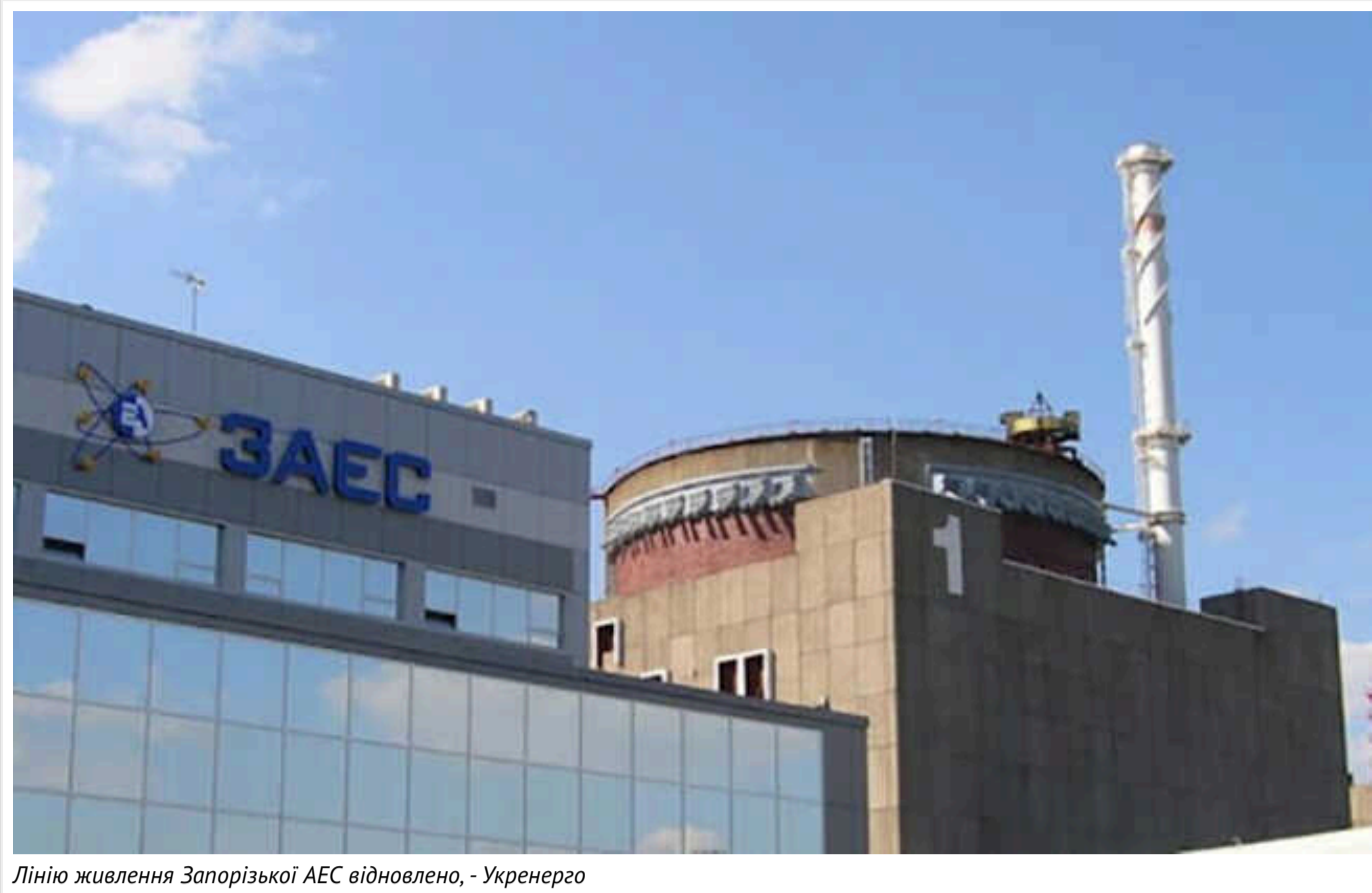
Лінію живлення Запорізької АЕС відновлено, - Укренерго
