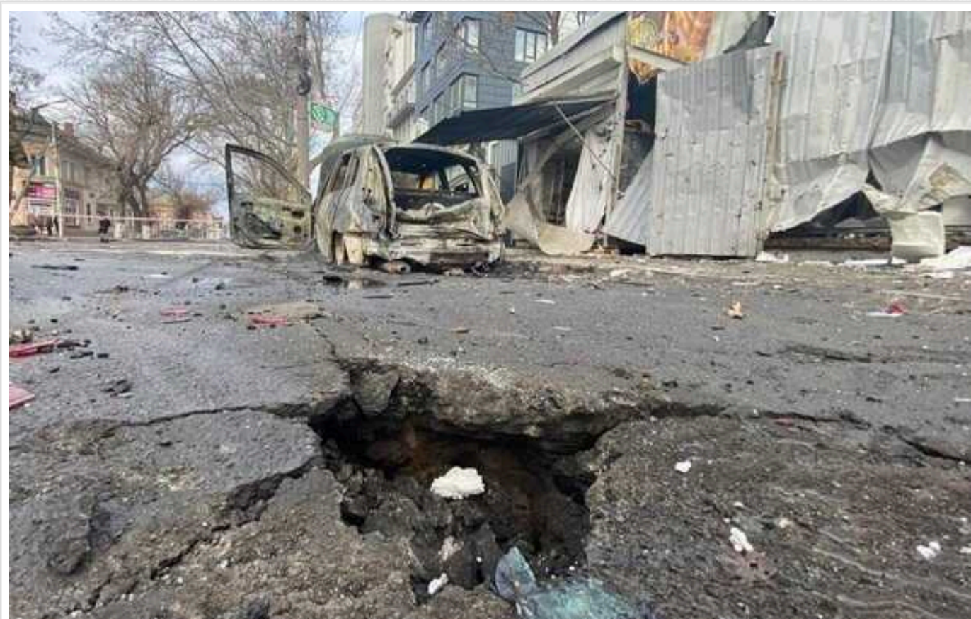
На Херсонщині внаслідок обстрілів пошкоджені дві багатоповерхівки, приватні будинки та навчальні заклади
