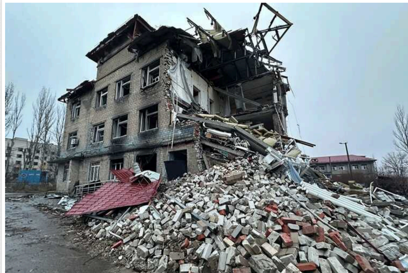
В ГУР показали, як рятуються від КАБів РФ в Авдіївці: "складають" одразу кілька будинків
